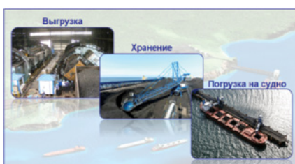
Порт Ванино (мыс Бурный). Технологическая схема перевалки угля на суда DWT 160 тыс. тонн
