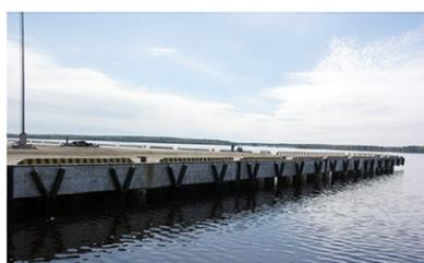
Взаимозаанкеренный больверк из стального шпунта, сборная железобетонная надстройка.
