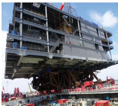
Astrakhan. Site de montage et d'assemblage de LUKOIL-Nizhnevolskneft. Glissement de la structure supérieure de la plate-forme de forage sur la barge de transport et d'assemblage
